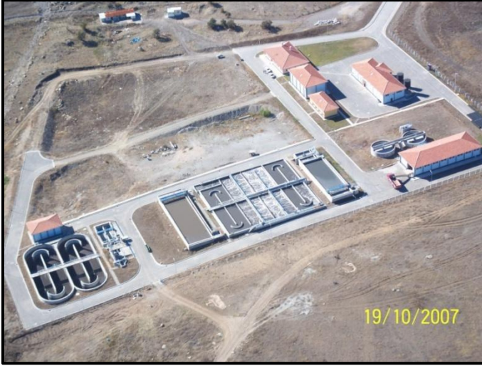
Foto 9. Atıksu Arıtma Tesis Alanından Bir Görünüm
